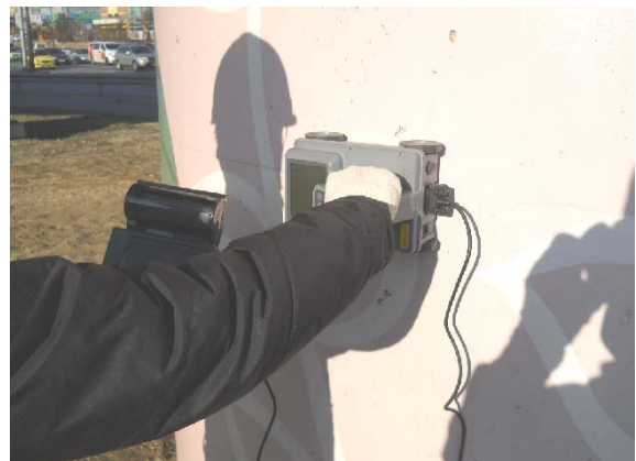
RC RADAR를 이용한 철근탐사
