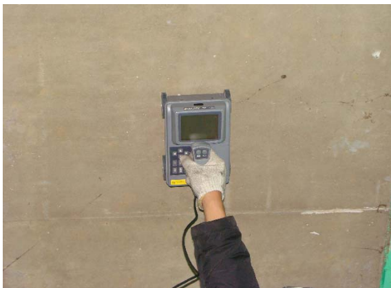
RC RADAR를 이용한 철근탐사
